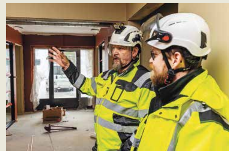
Tommi Salo och Sebastian Storholm är nöjda med hur bygget framskrider. Tanken är att personalen ska flytta in i början av maj.
