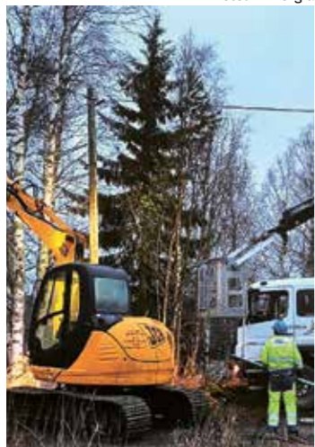
Just nu pågår röjningsarbete under ledningsgatorna på Vetelin Energias område.
